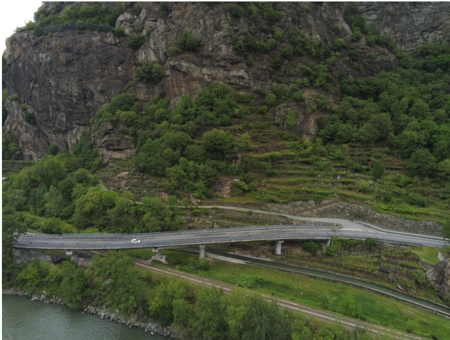
Figura 1. Vista della porzione orientale della Strada Romana delle Gallie in corrispondenza dell'intersezione con la SS26.
