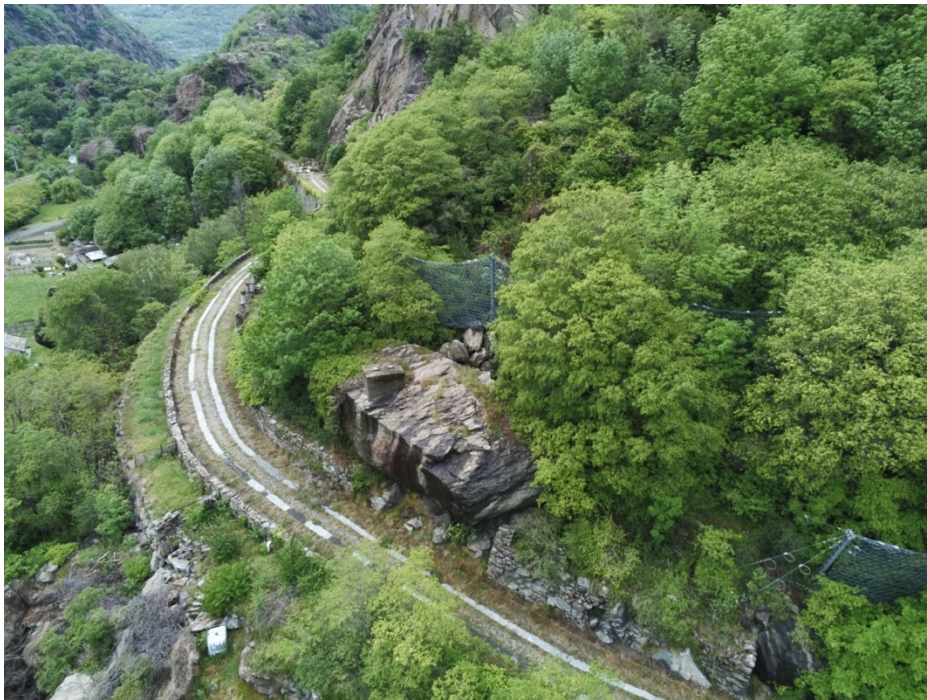
Figura 3. Vista della porzione della Strada Romana delle Gallie in corrispondenza della conoide di crollo.
