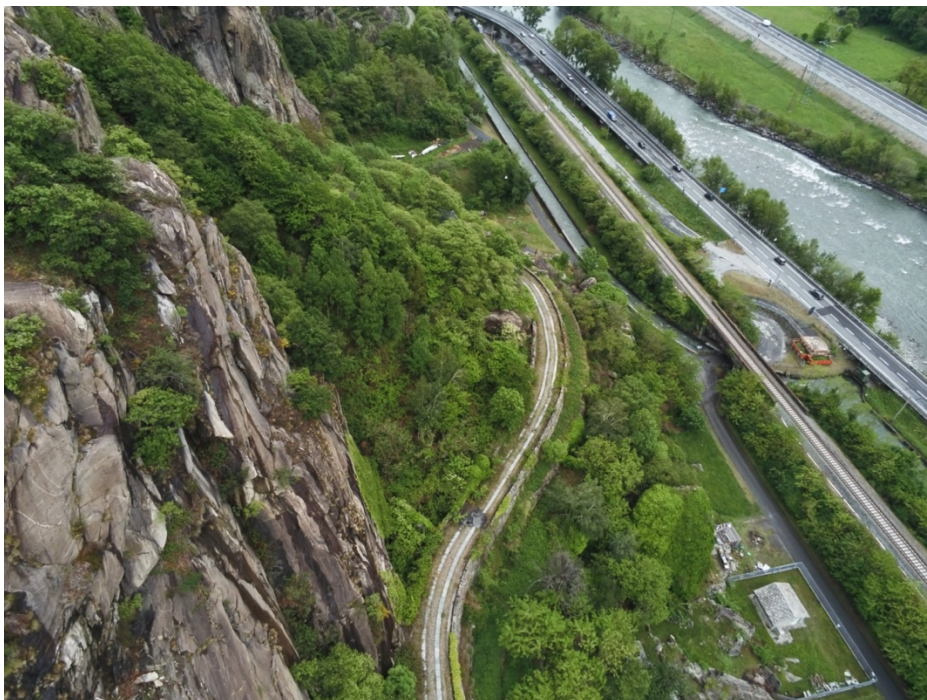
Figura 6. Vista della Strada Romana delle Gallie e della viabilità locale (Altra strada) a valle.
