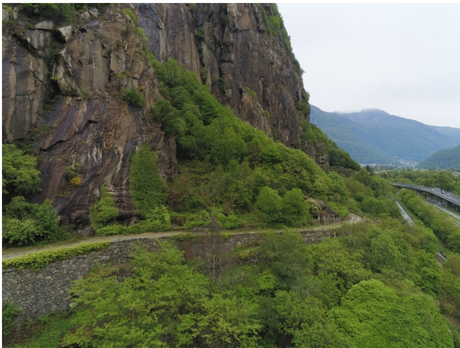
Figura 4. Vista della porzione centrale della Strada Romana delle Gallie, con i ruderi di antiche costruzioni.
