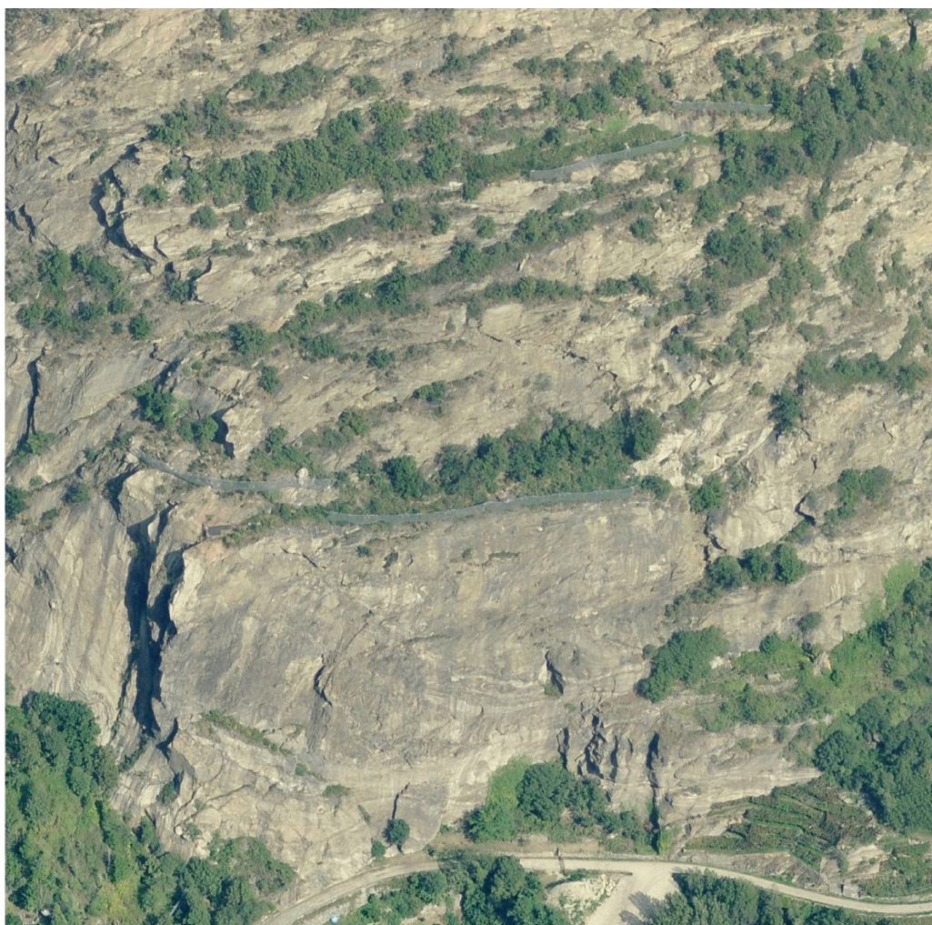
Figura 36. Vista frontale della porzione di parete nella quale sono installate le barriere paramassi.
