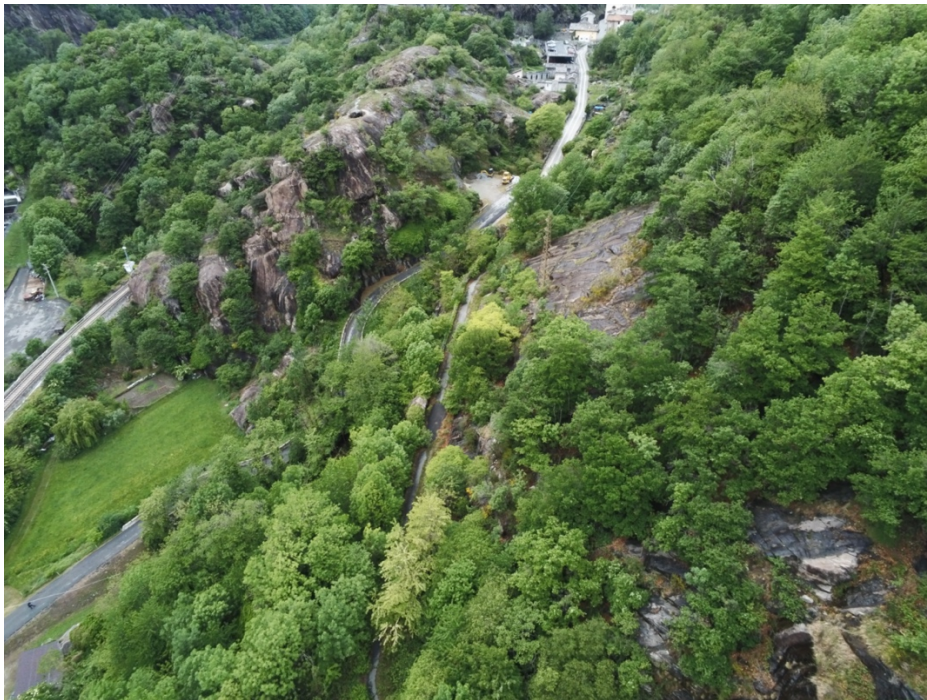
Figura 5. Vista della porzione occidentale della Strada Romana delle Gallie invasa dalla vegetazione.
